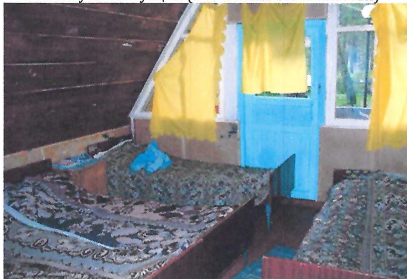
Фото 10. Пути эвакуации (в т. ч. зоны безопасности)
